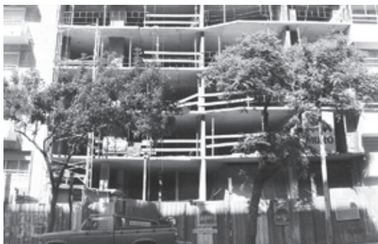
Edificio deshabitado en construcción
